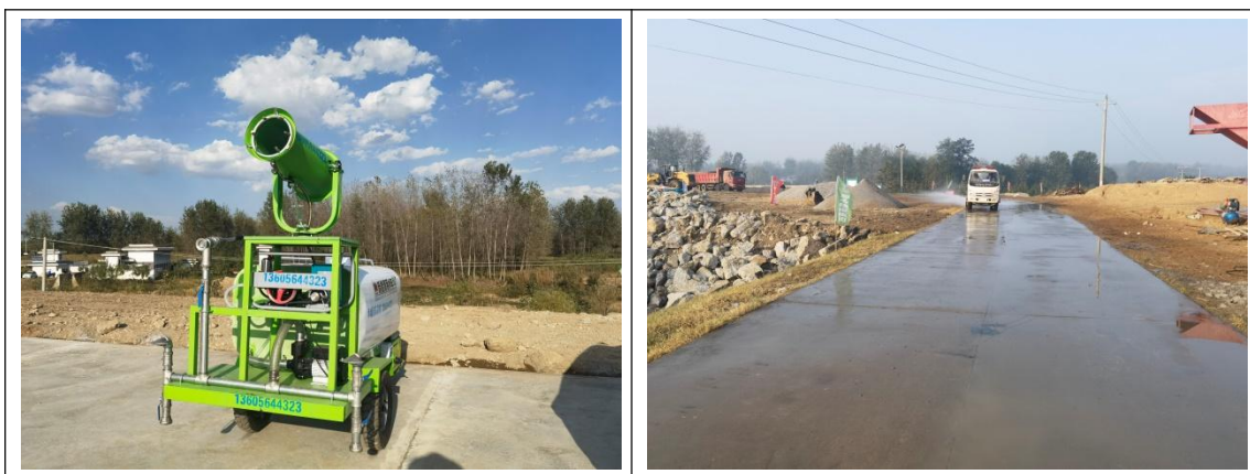
图 5-5 洒水扬尘防护
